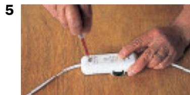
**1. Démontez le variateur en dévissant ses vis d'assemblage.**
